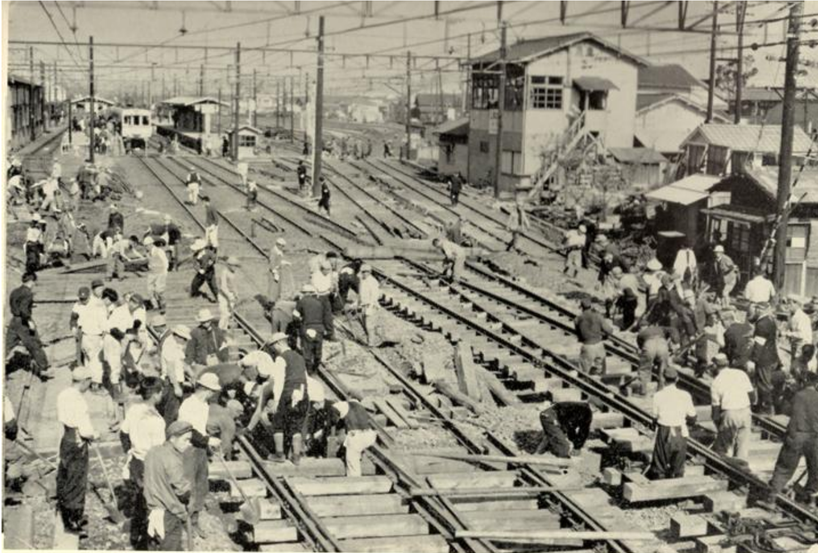
塩浜駅付近の拡幅作業 (11月23日 手前中川方)
